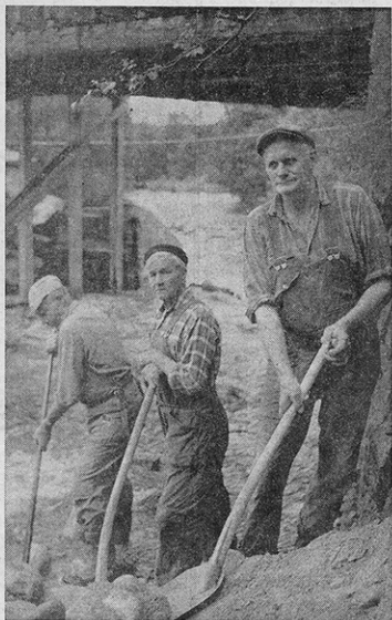
Josel Ferlin (längst t.v.), Olov Grönberg och Valter Storm reparerar bron vid Kvarnåker.
