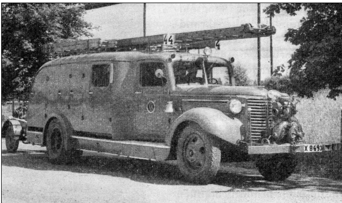
Brandbil införskaffad 1947 till Sandviken Järnverk, byggd av Järbo karosseriverkstad på ett Chevroletchassi från ca 1939/40. Hytten har plats för nio man. Bilen har frontmatad bilmotorpump. Reg. X8493. Uppgifter från Tommy Hjort.
