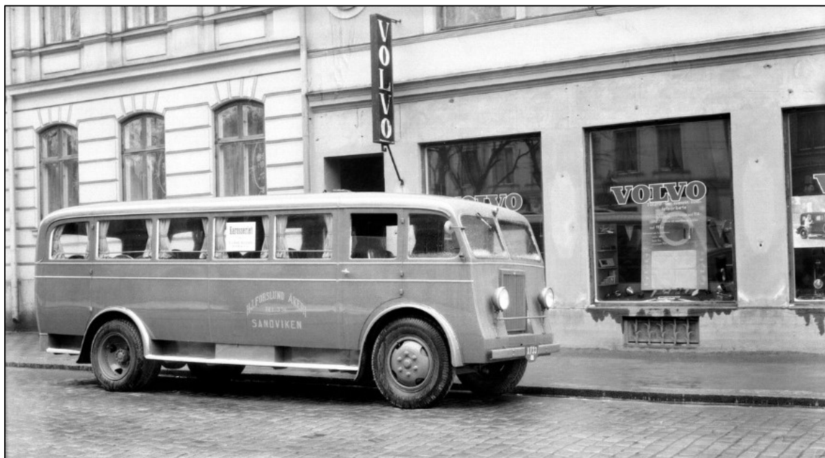
Buss till H. J. Forslund Åkeri, Tel: 334 Sandviken. Enligt en skylt i bussens ena sidofönster verkar karossen vara tillverkad av "Järbo(?) Karosserifabrik" på ett Volvo LV70-chassi. Året är 1934. Karossen är avlyftbar med en skarv bakom hytten, så att ett lastflak kan monteras som alternativ. Fotograferad 1939(!) (enligt uppgift) av Carl Larssons Fotografiska Ateljé AB. Bilden finns hos Länsmuséet Gävleborg med nr XLM.CL007554.
