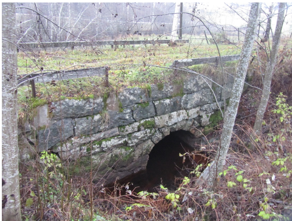
Figur 22. Stenvalvsbron står kvar än idag. Stenvalvsbro © Fotograf Bo Ulfhielm, Läns museet Gävleborg
